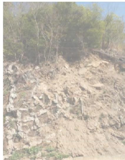
2017 年 2 月 17 日現況，已發現崩塌及坡面破損裸露
