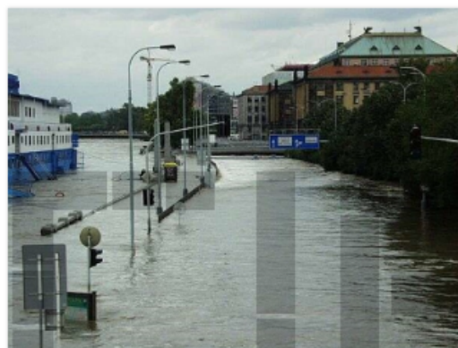
捷克布拉格-伏爾塔瓦河防洪工程
