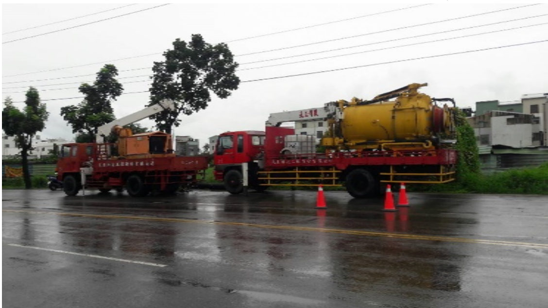
圖 11、(元正科技)移動式抽水機進駐中正西路
