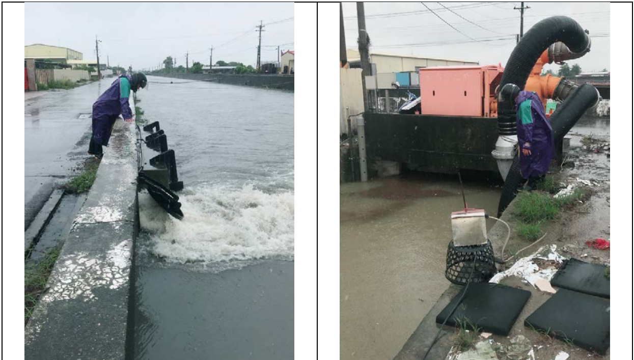
圖 9、0615 豪雨期間警戒組巡查(大甲排水二號抽水機及排水)情形
