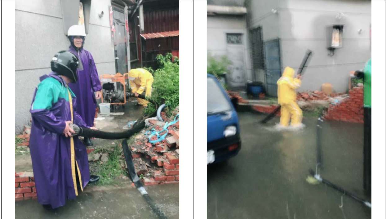
圖 10、0615 豪雨期間協助使用小型抽水機情形
