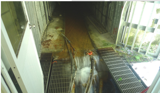
圖 1 梨山地區引用排水廊道地下水情形
